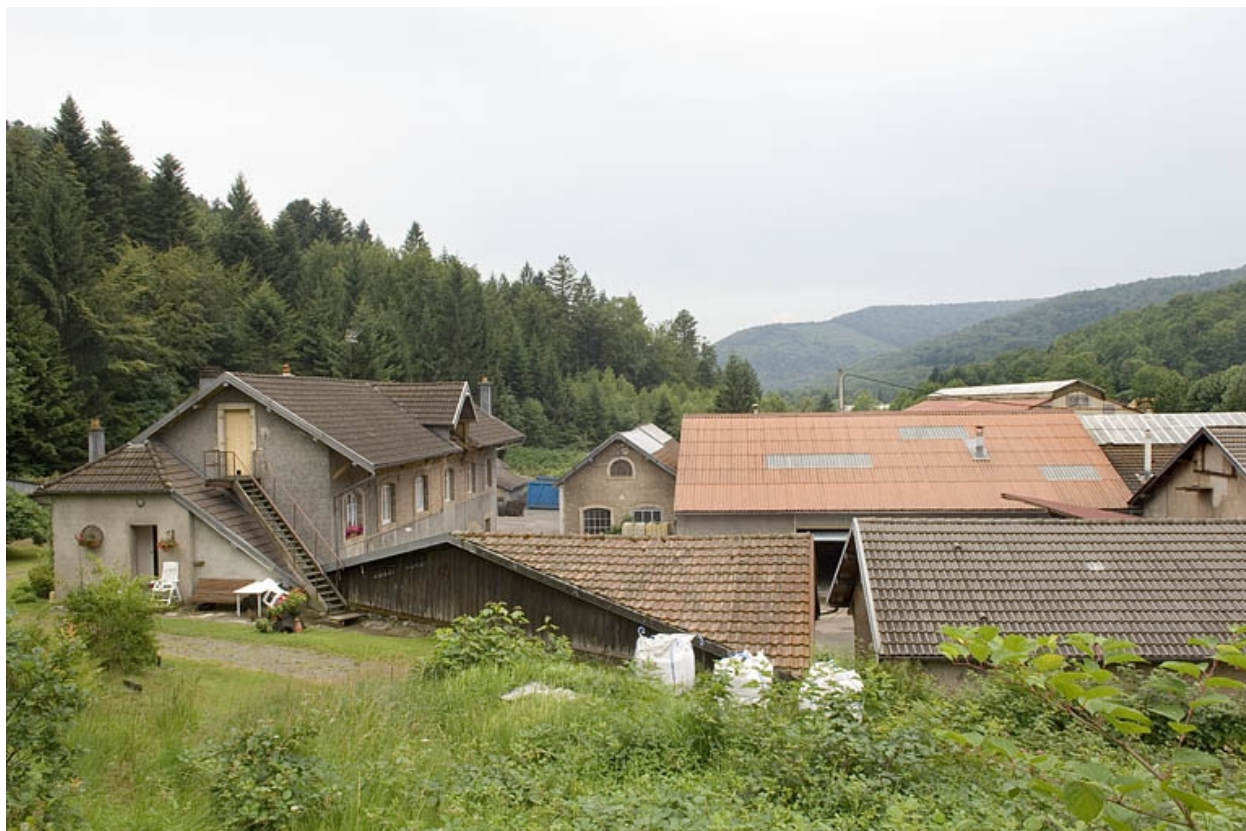
Logement et toitures des ateliers de fabrication.
