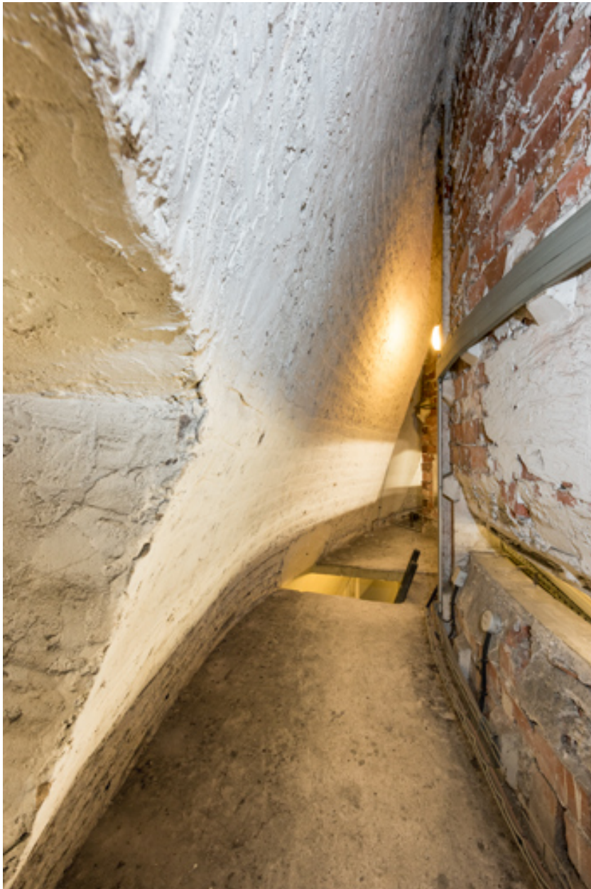
Galerie entre la paroi extérieure (à gauche) et le tambour de la coupole.
