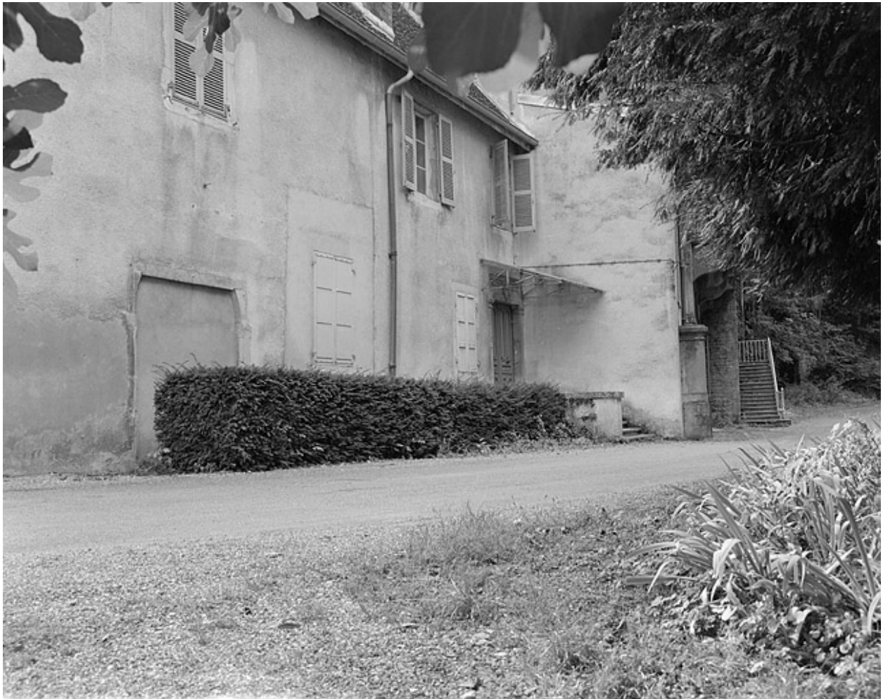
Façade latérale droite du bâtiment A.
