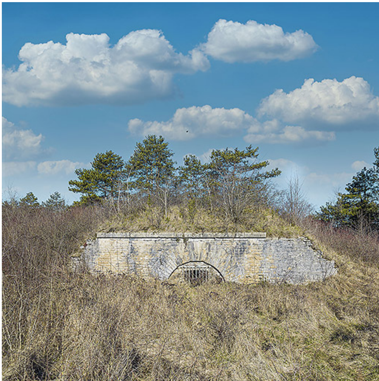
Une des batteries dépendantes du fort.
