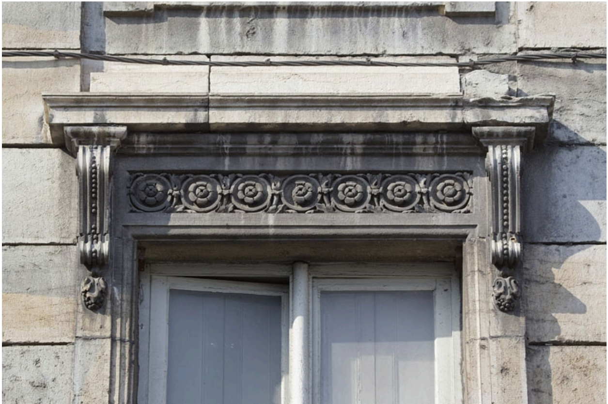
Façade antérieure, fenêtre du premier étage : détail du linteau décoré de fleurons.
