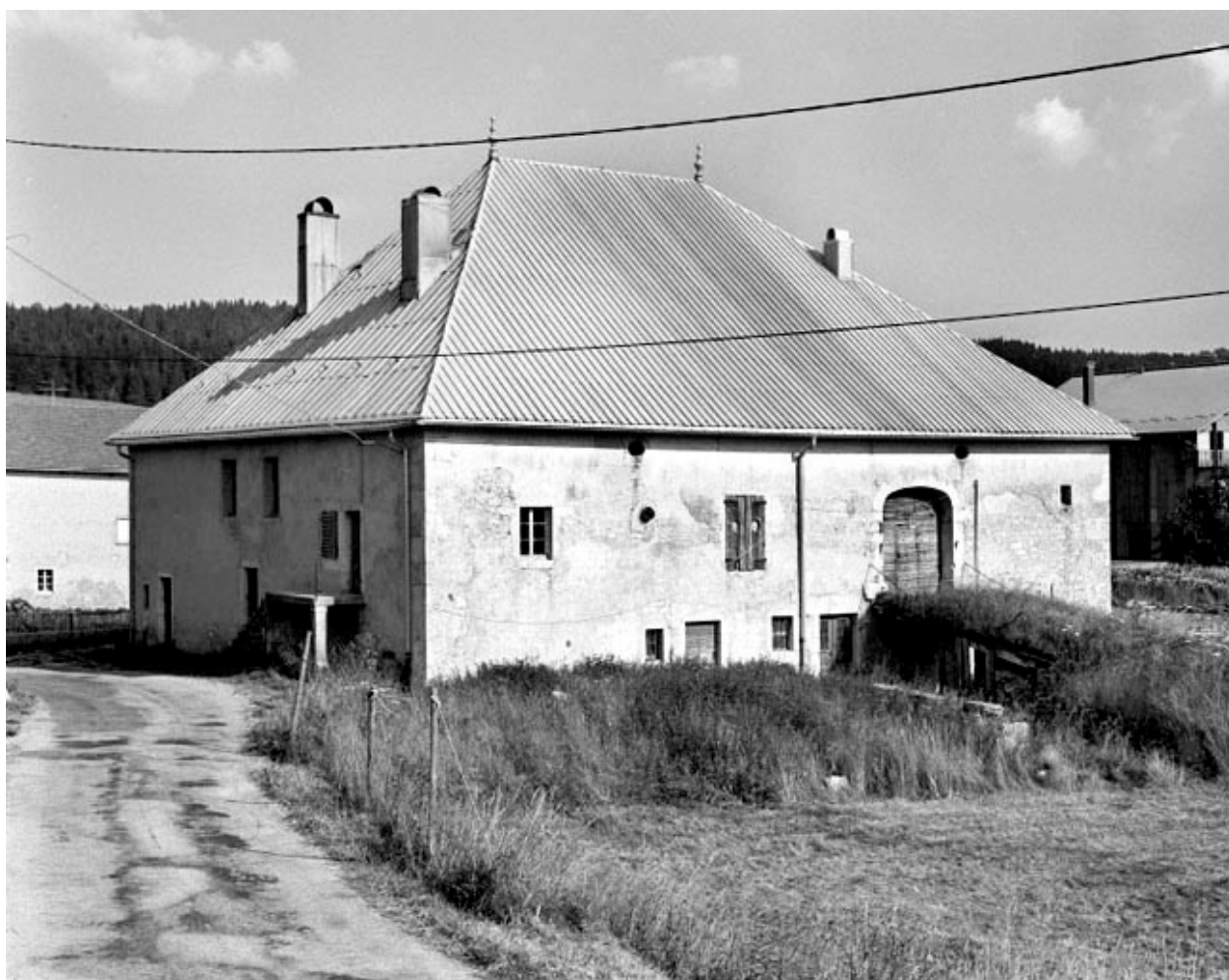
Façade postérieure avec accès aux parties agricoles.
