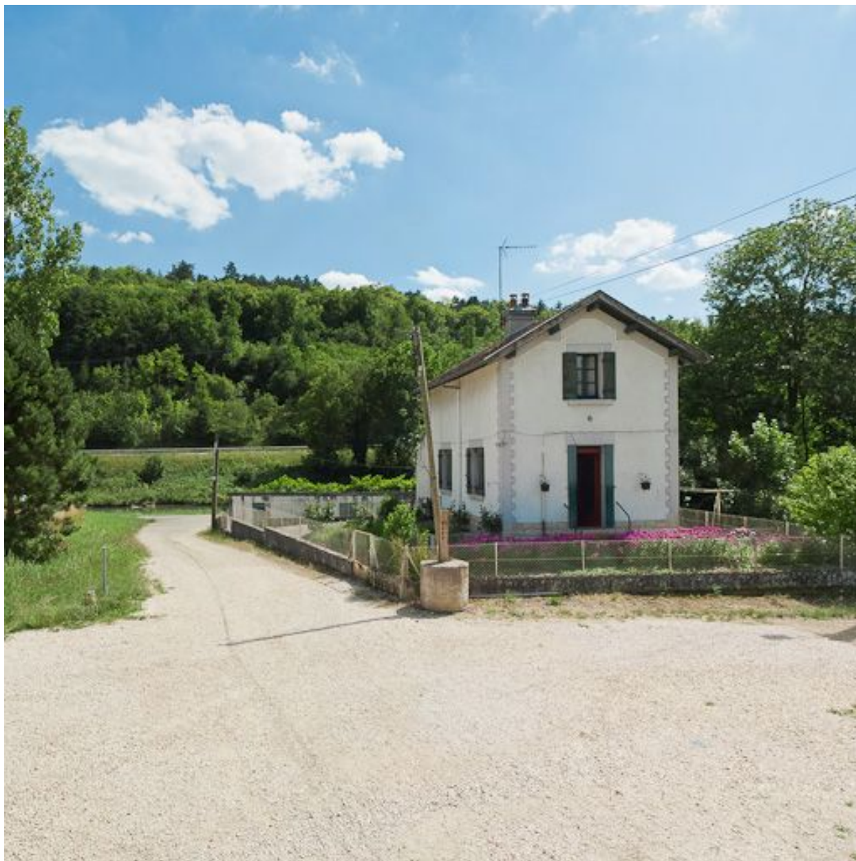
Vue de la maison de garde-barrière.
