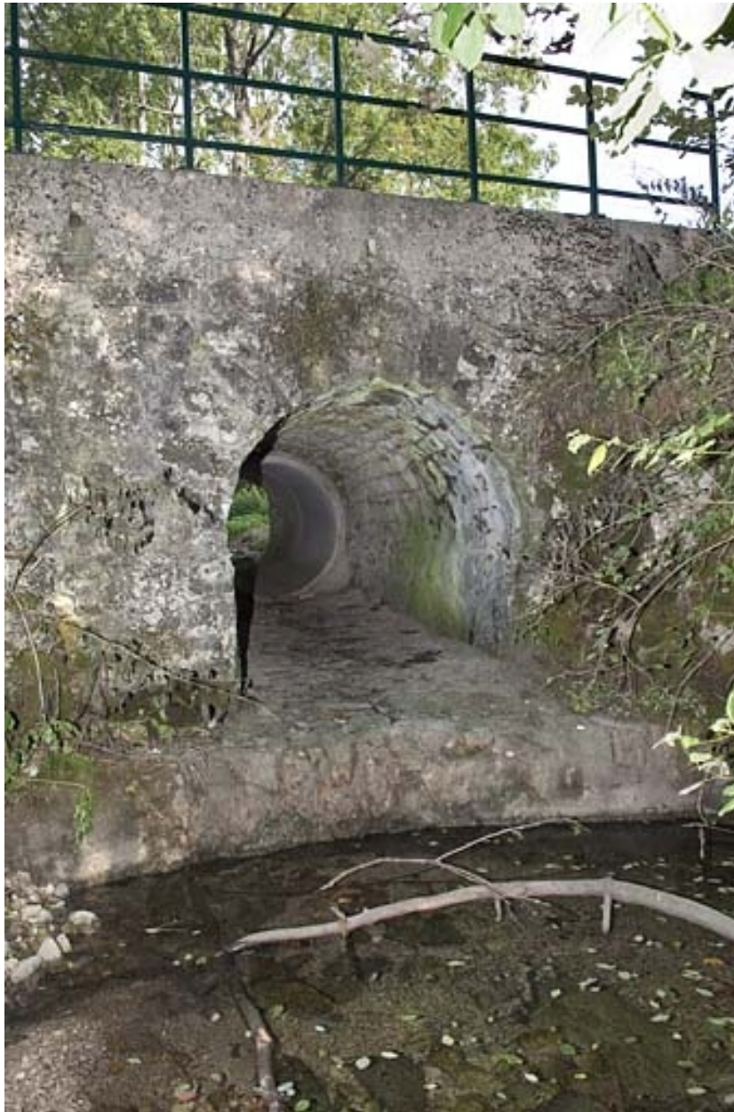
Pont sur la Servante (n° 5), vu depuis l'aval.
