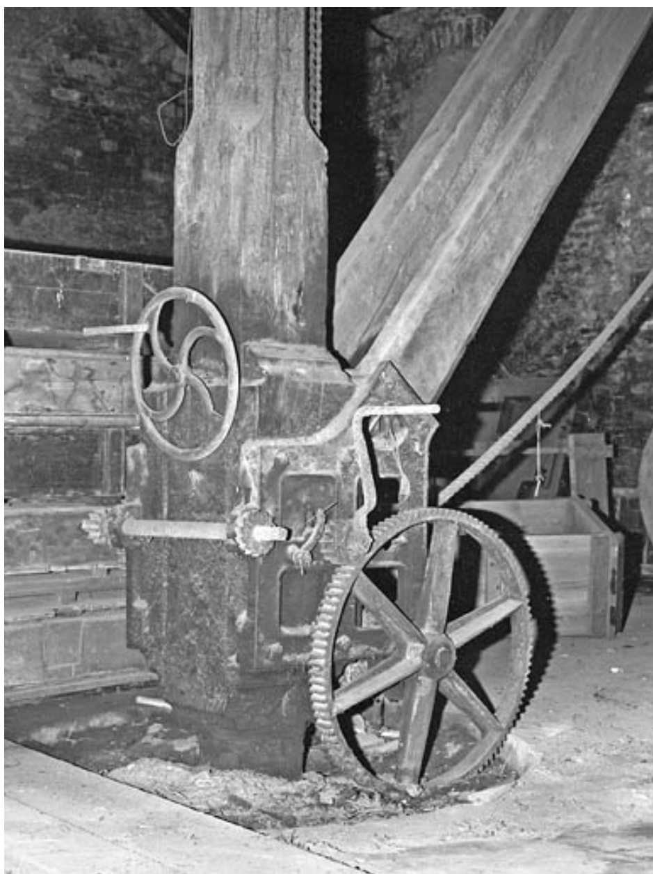
Base de la grue à potence.
