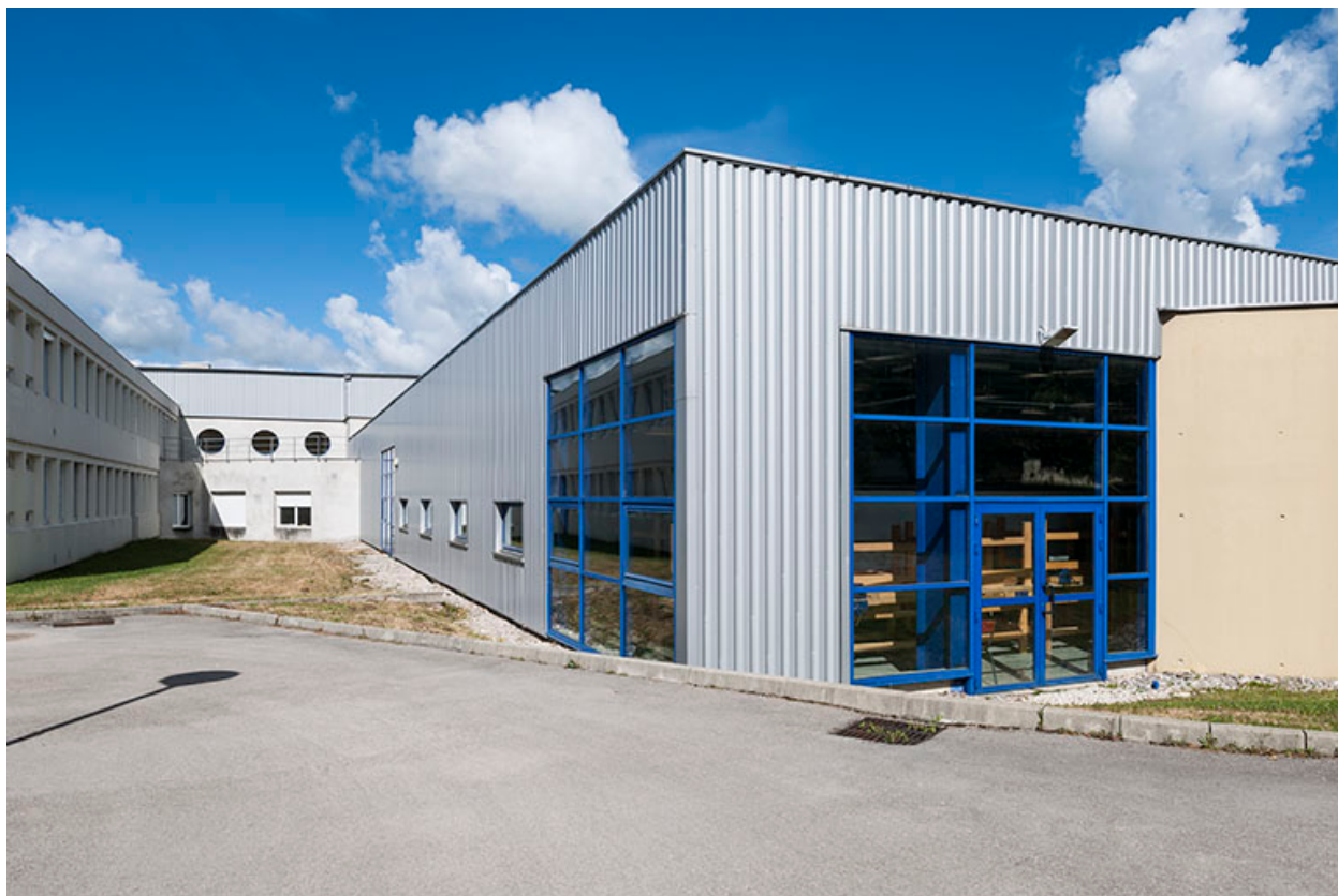
Ateliers, façade postérieure : détail.
