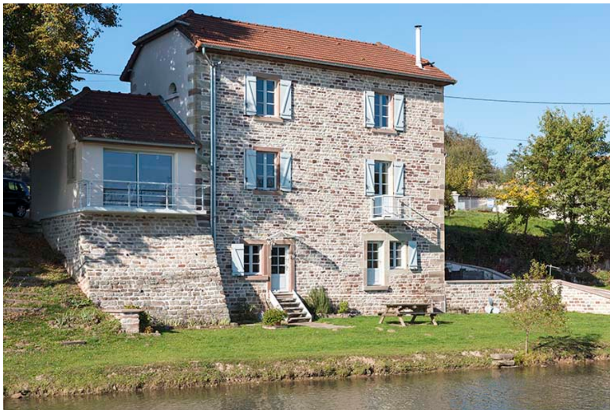
Maison située face au canal (2).
