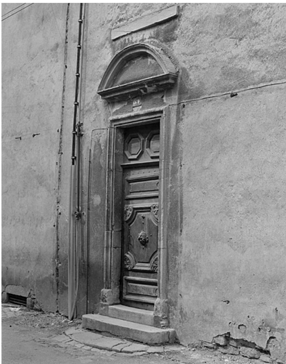
Façade latérale, porte d'entrée.
