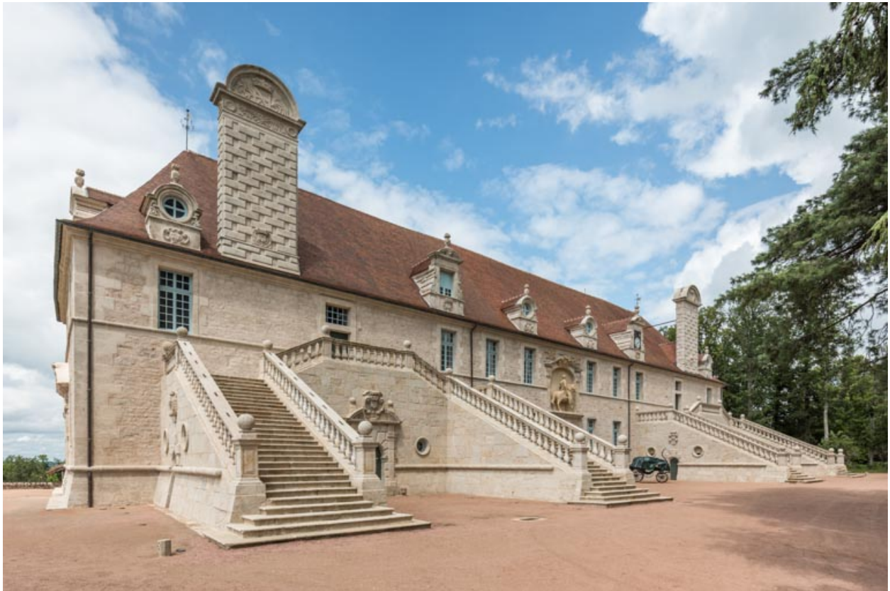
Façade sud-est, vue d'ensemble depuis le sud.
