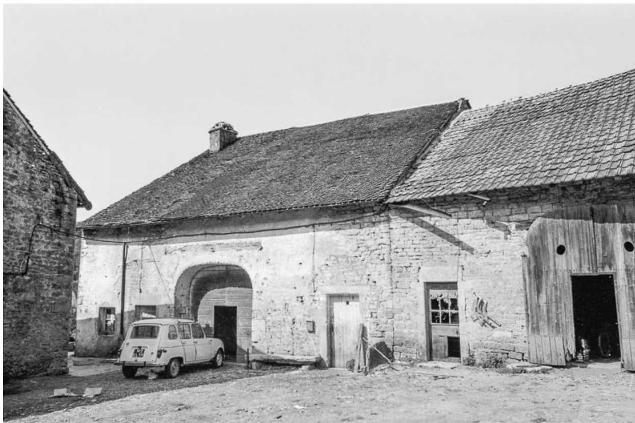
Ferme cadastrée ZK 40 : façade postérieure.
