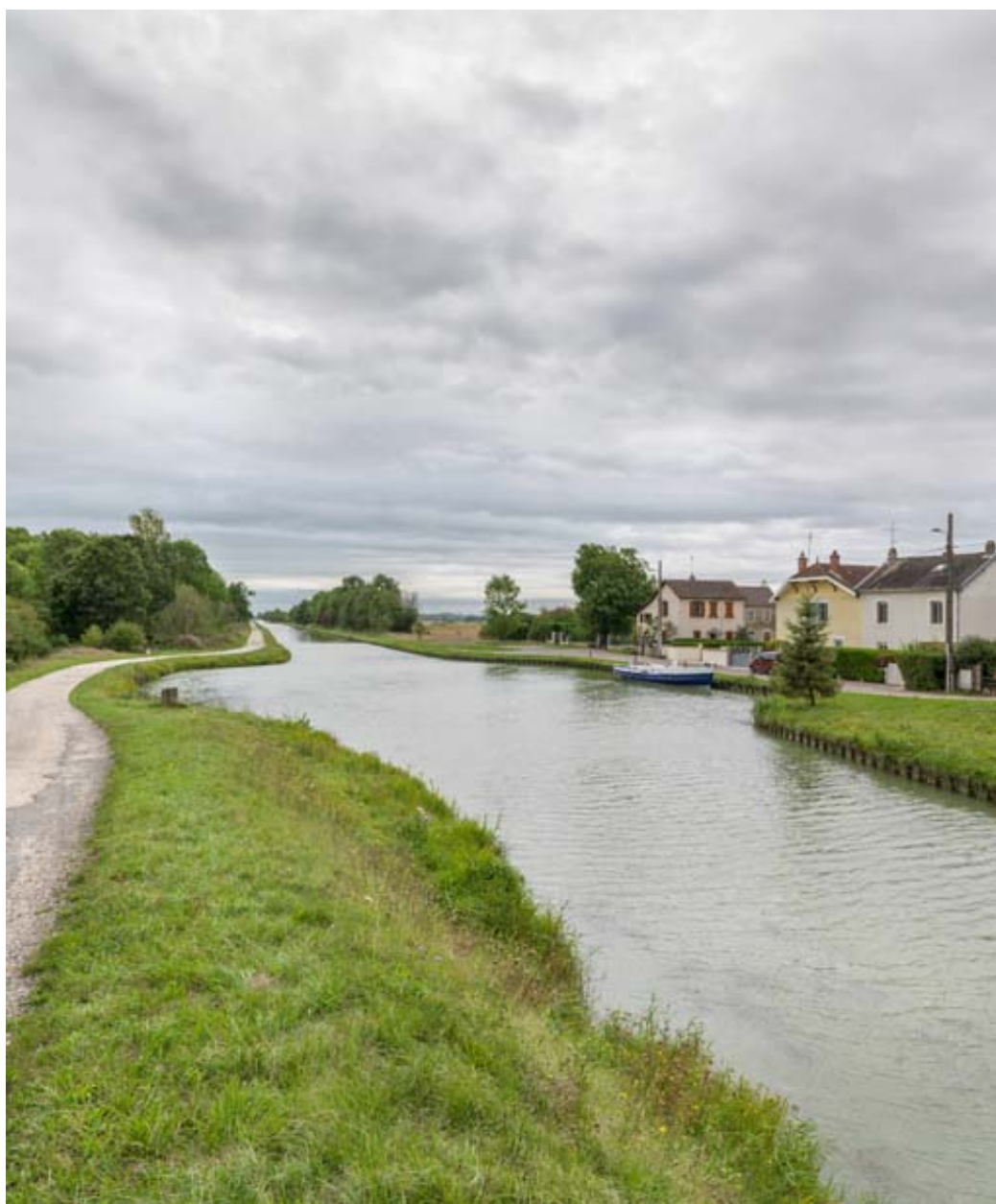
Vue d'ensemble de la gare d'eau.
