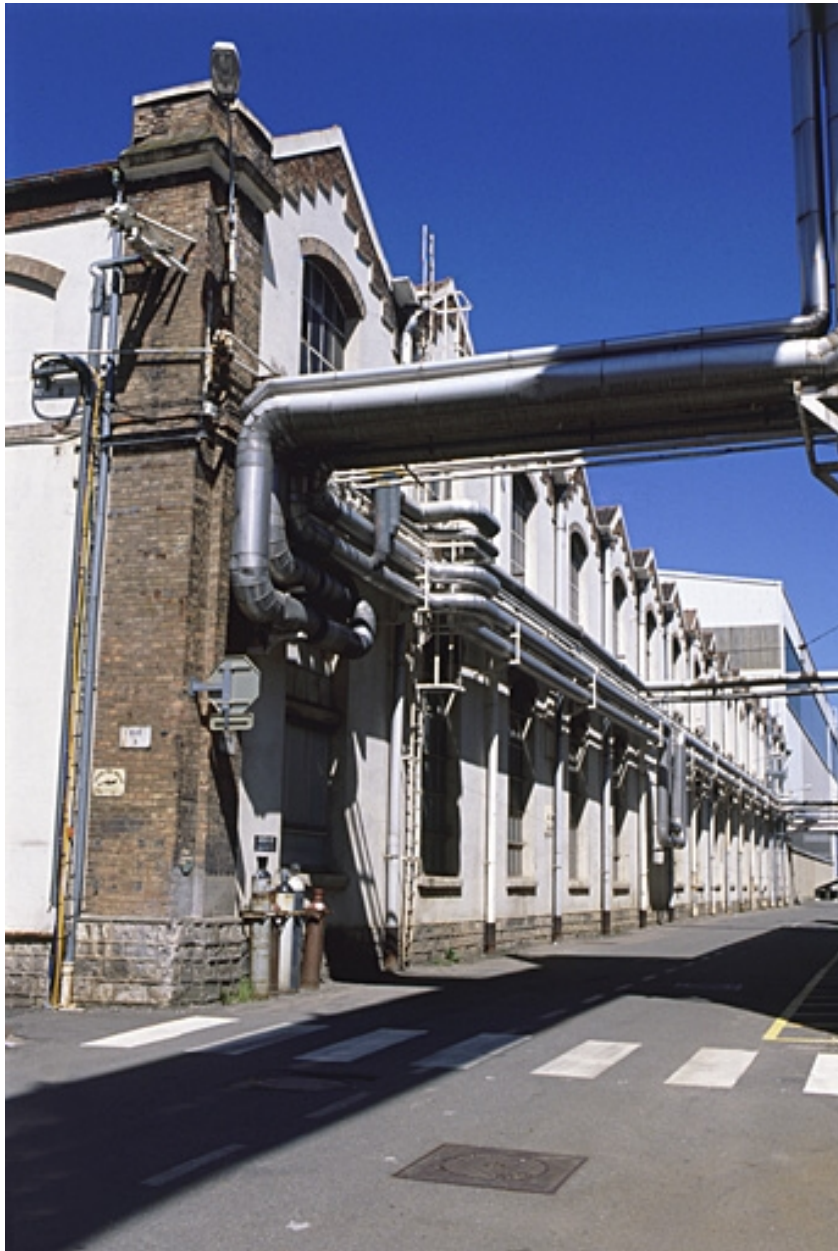
Façade est de l'ancien atelier de grosse construction sur l'avenue 5.
