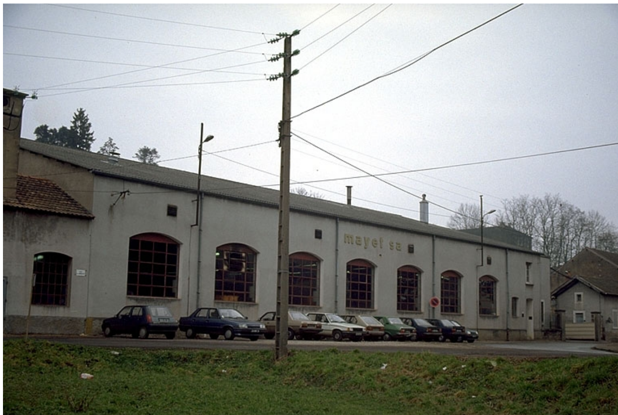
Façade antérieure de l'atelier de fabrication.
