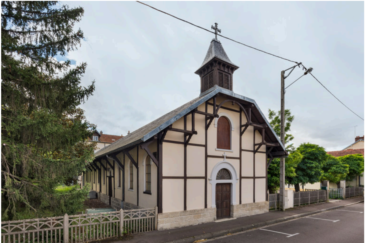
Façades nord (antérieure) et est. Vue de trois quarts.
