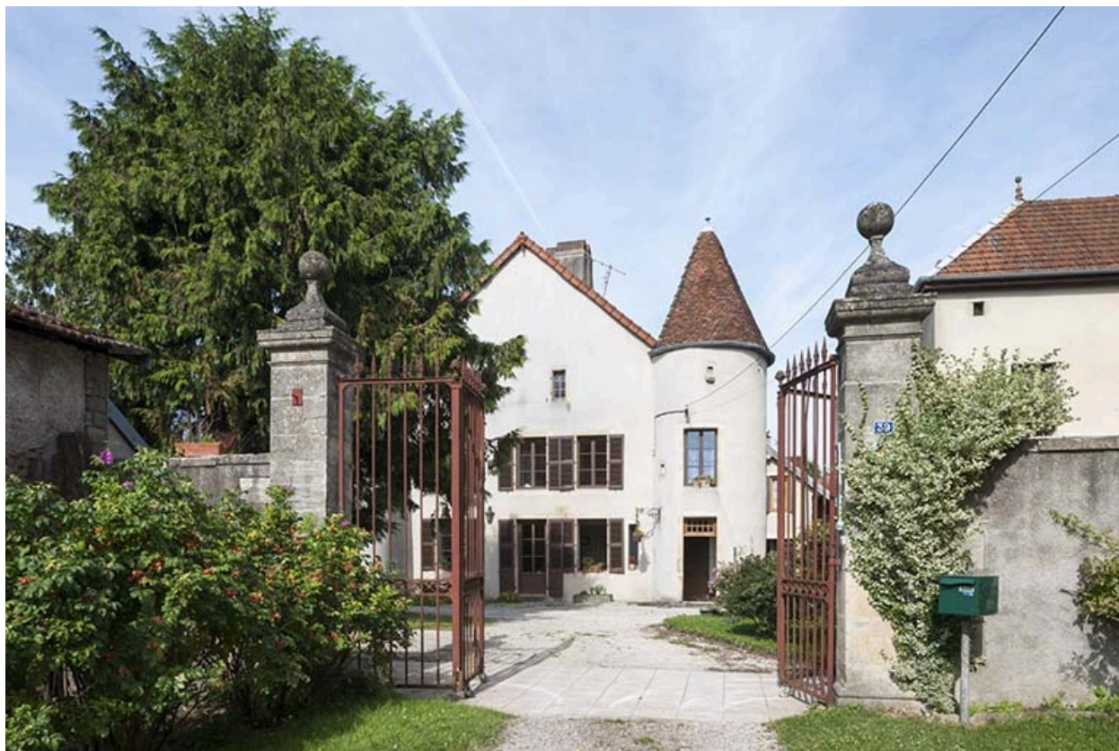
Vue rapprochée depuis la Grande Rue.
