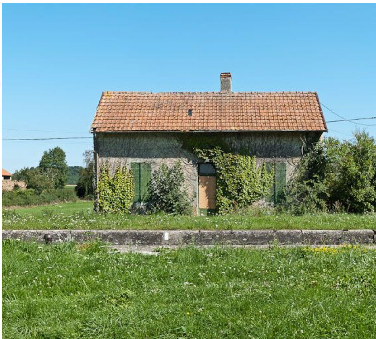
Vue de face de la maison éclusière.
