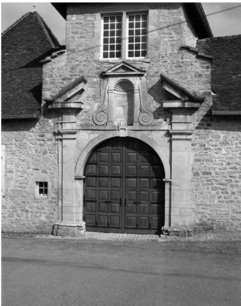
Pavillon d'entrée, le portail.
