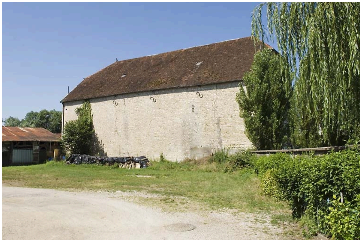
Façade est du haut fourneau.
