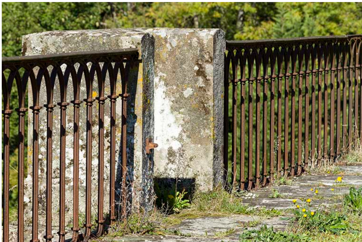
Le garde-corps maçonné d'une culée.
