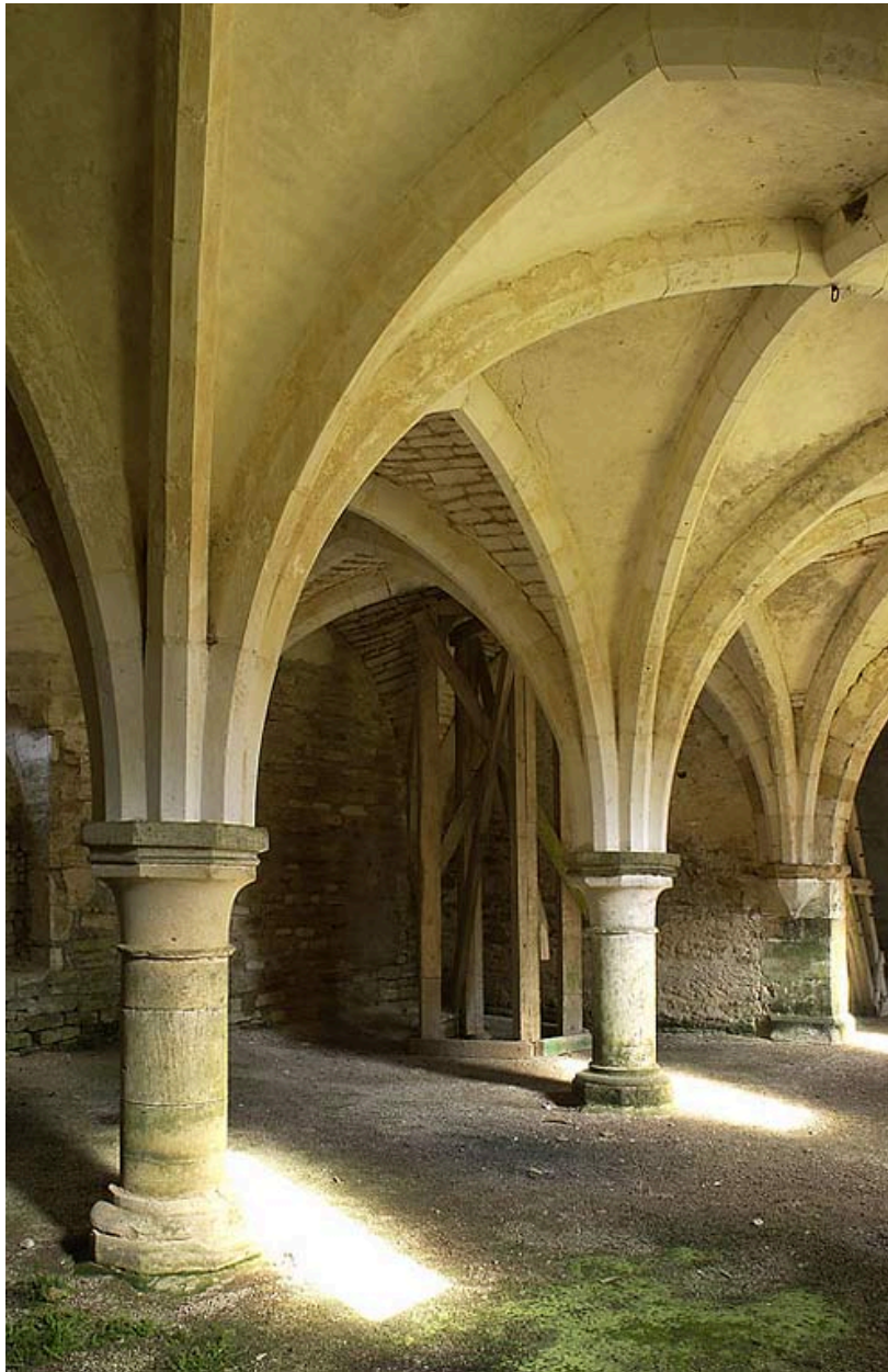
Cellier : rez-de-chaussée, salle sud vue depuis l'angle sud-est.
