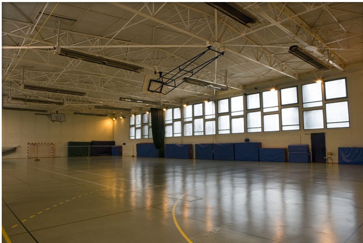
Bâtiment F1. Vue intérieure gymnase.
