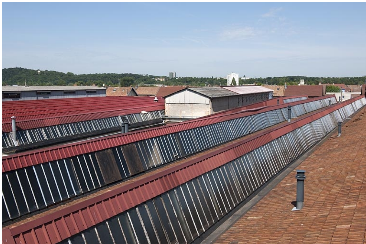
Sheds de l'atelier de montage des voitures.
