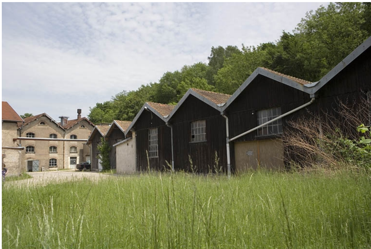
Magasin industriel (désaffecté). Vue de trois quarts.
