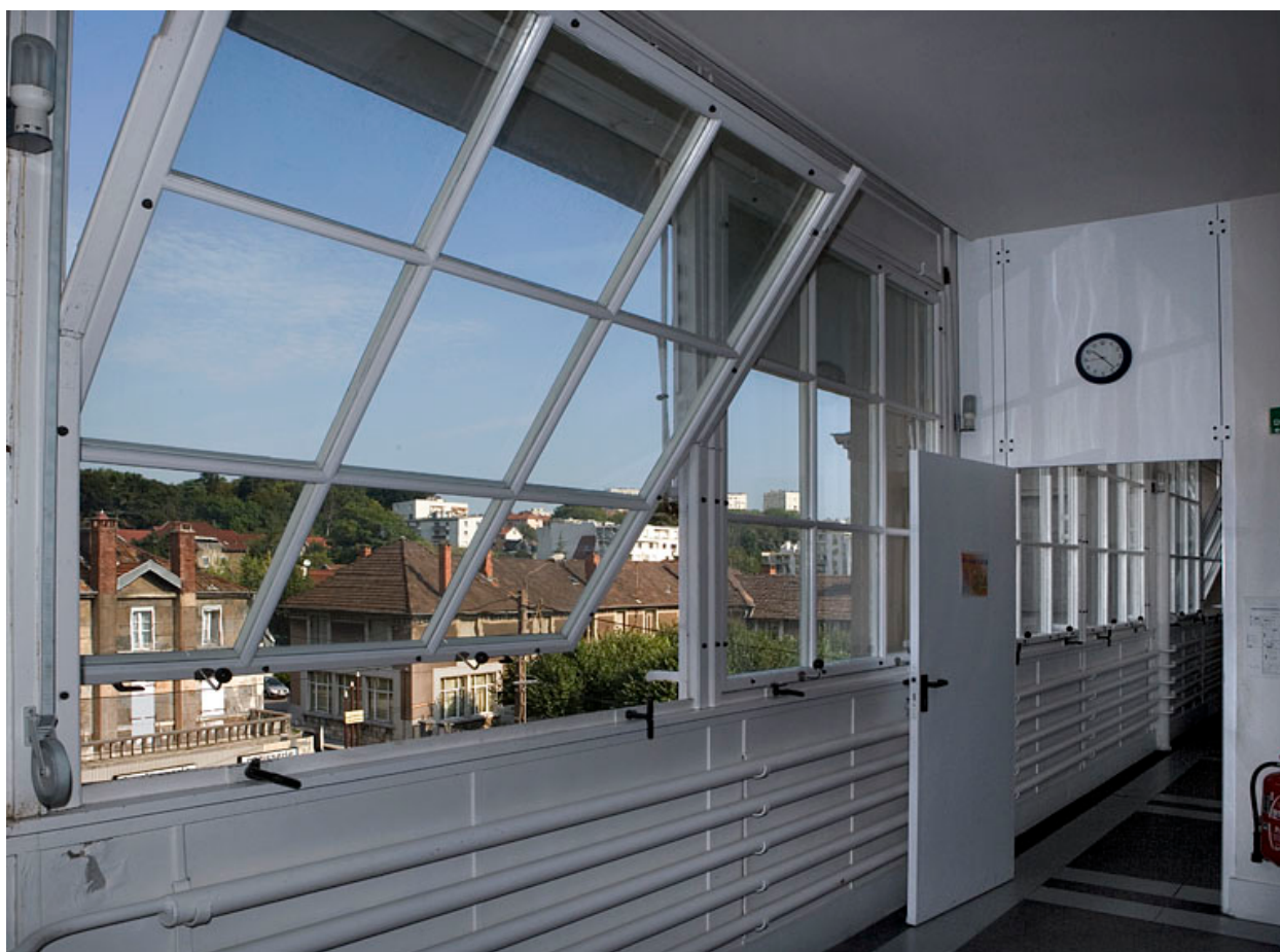
Deuxième étage : intérieur, avec couloir et fenêtres à l'italienne.
