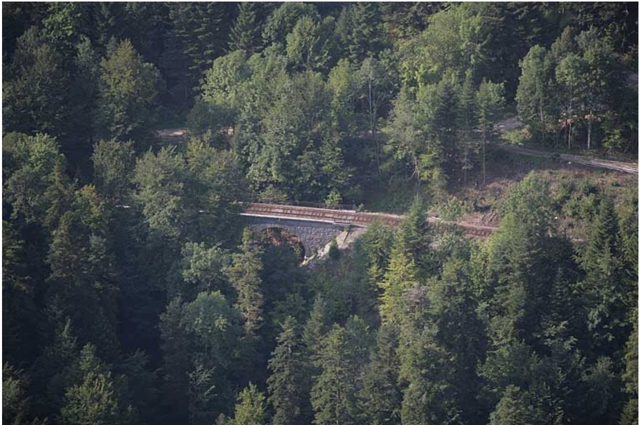
Vue aérienne du viaduc, depuis le nord.
