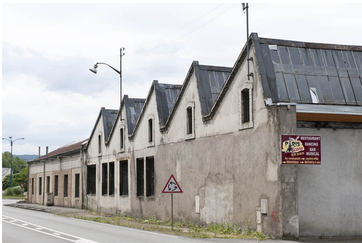
Façade orientale des ateliers de fabrication nord.
