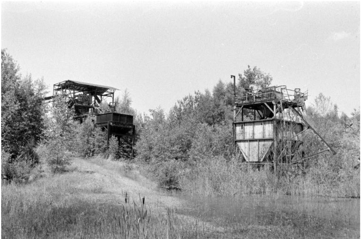
Anciennes installations, en 1988 : trémie et poste de concassage (I).
