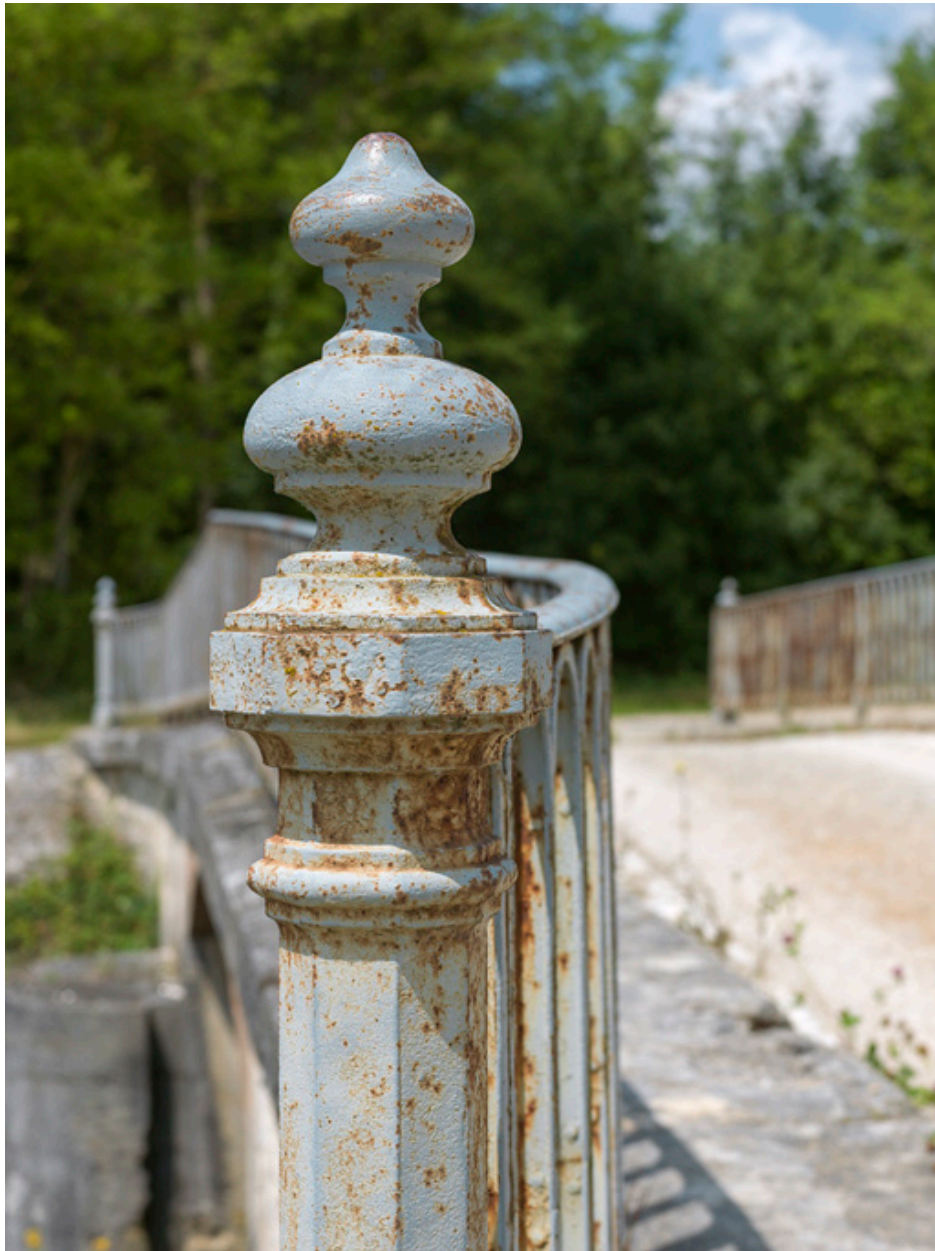
Détail du garde corps.
