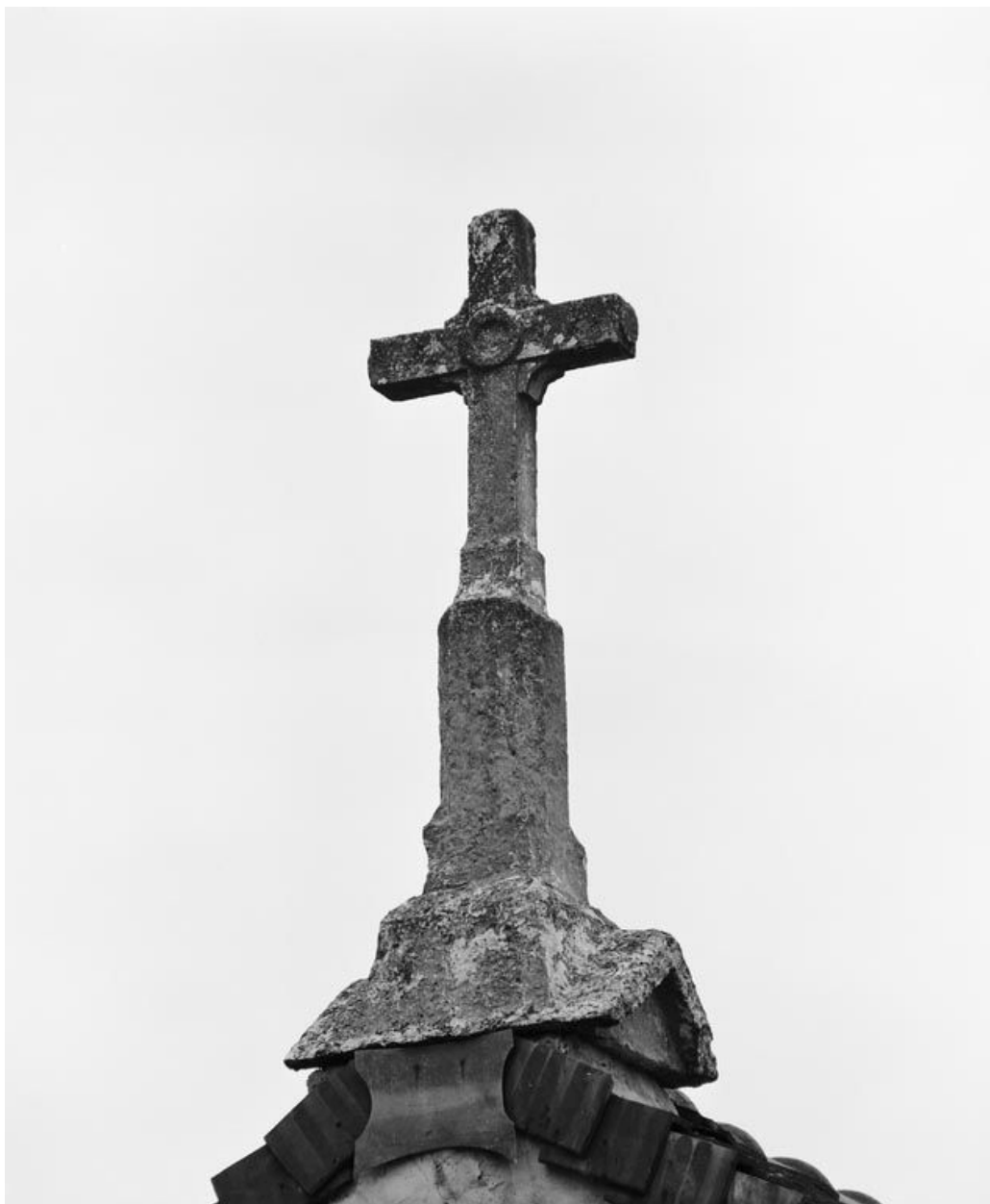
Croix amortissant le pignon du porche.
