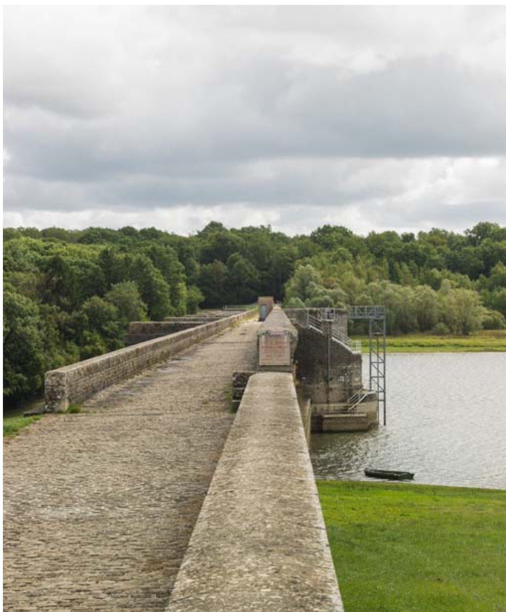
Vue rapprochée du barrage.
