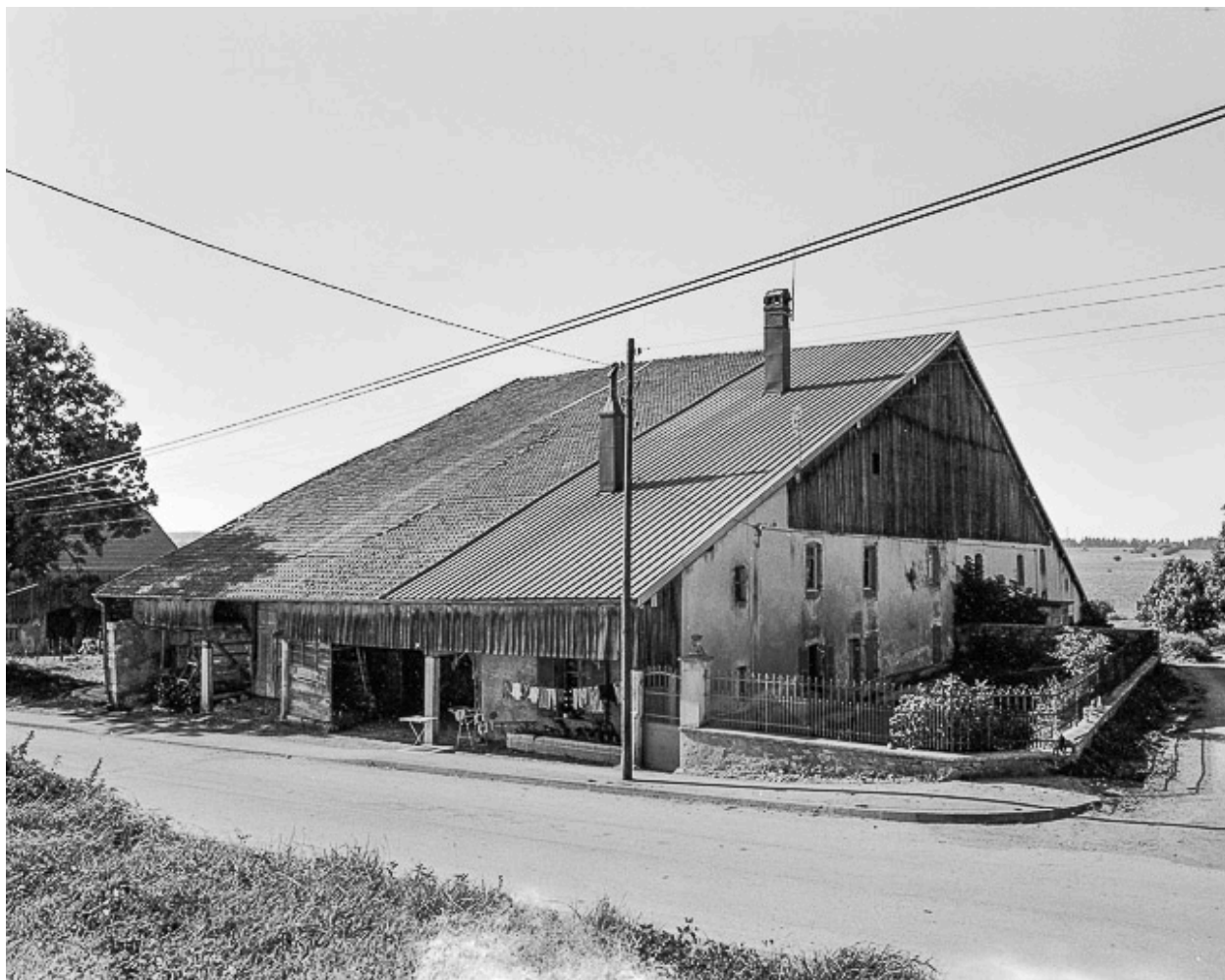
Façade antérieure et mur gouttereau sur rue.
