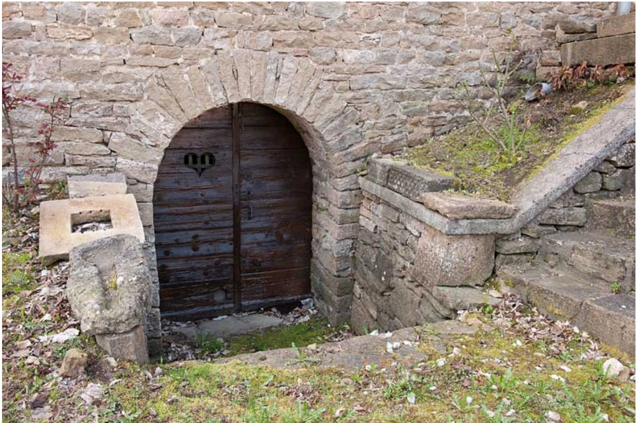
Grange : porte de cave sur la façade antérieure.
