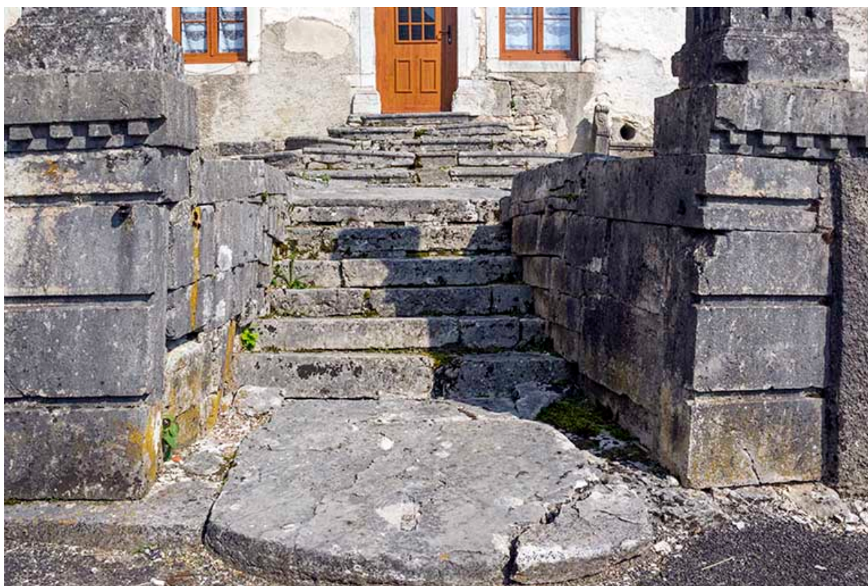
Terrasse surélevée : escalier.
