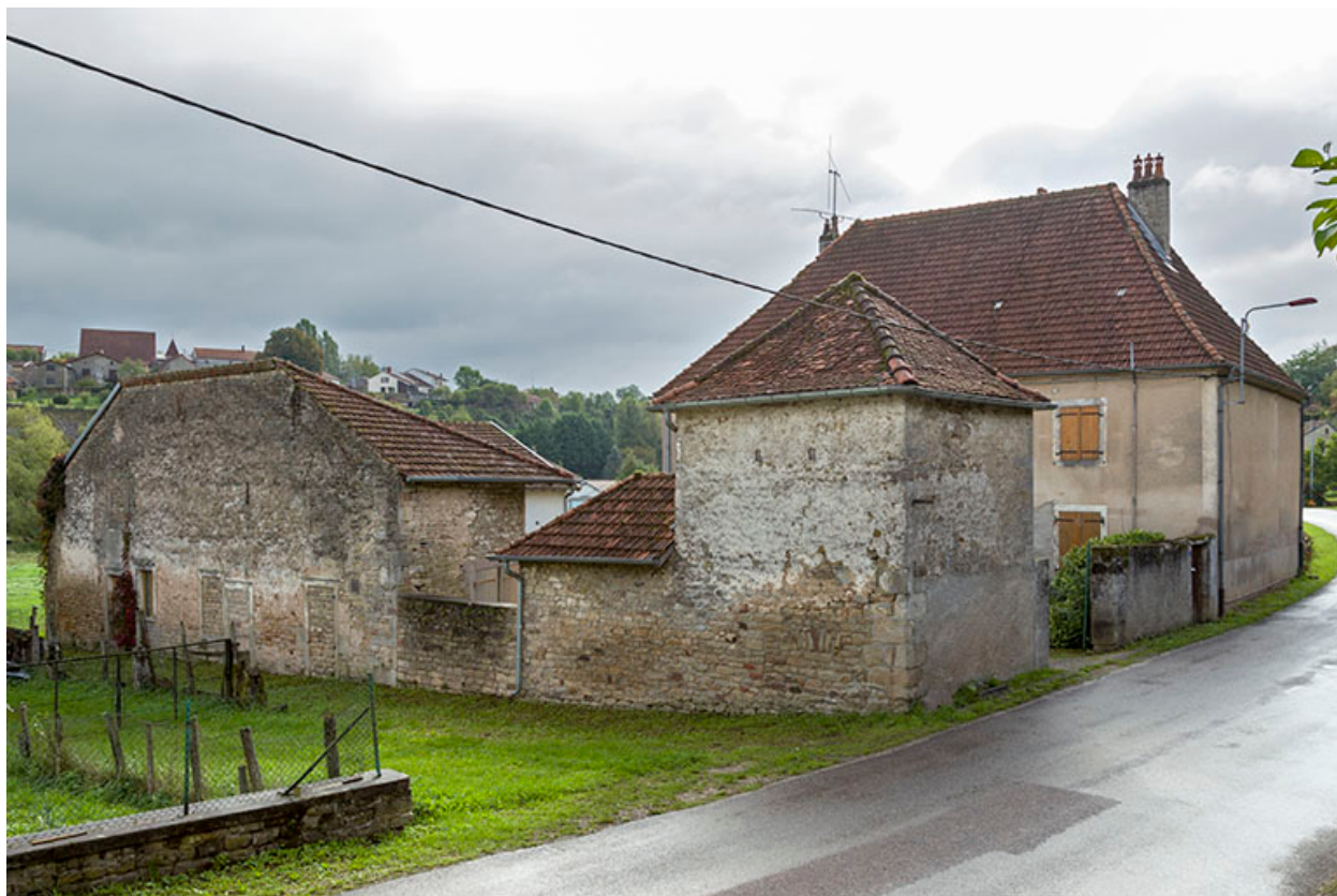
Vue d'ensemble depuis la rue du Presbytère.
