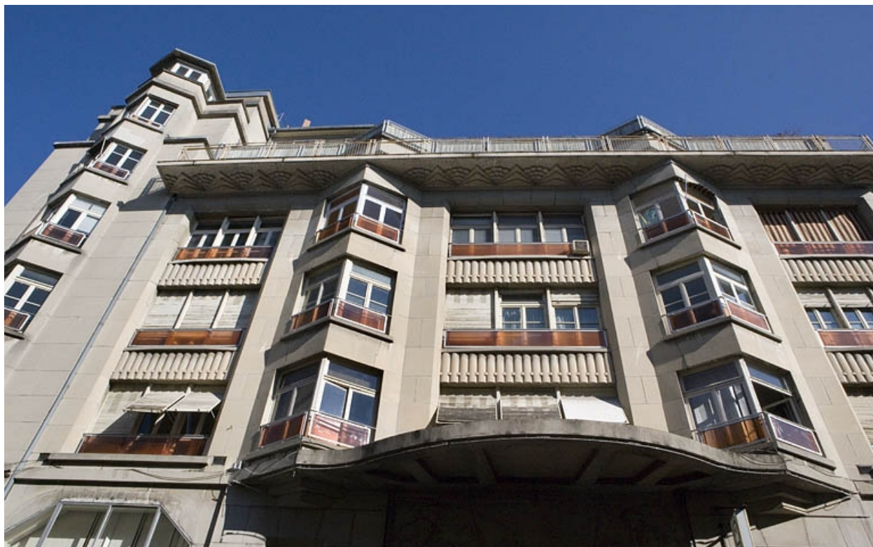
Façade : auvent et balcons.
