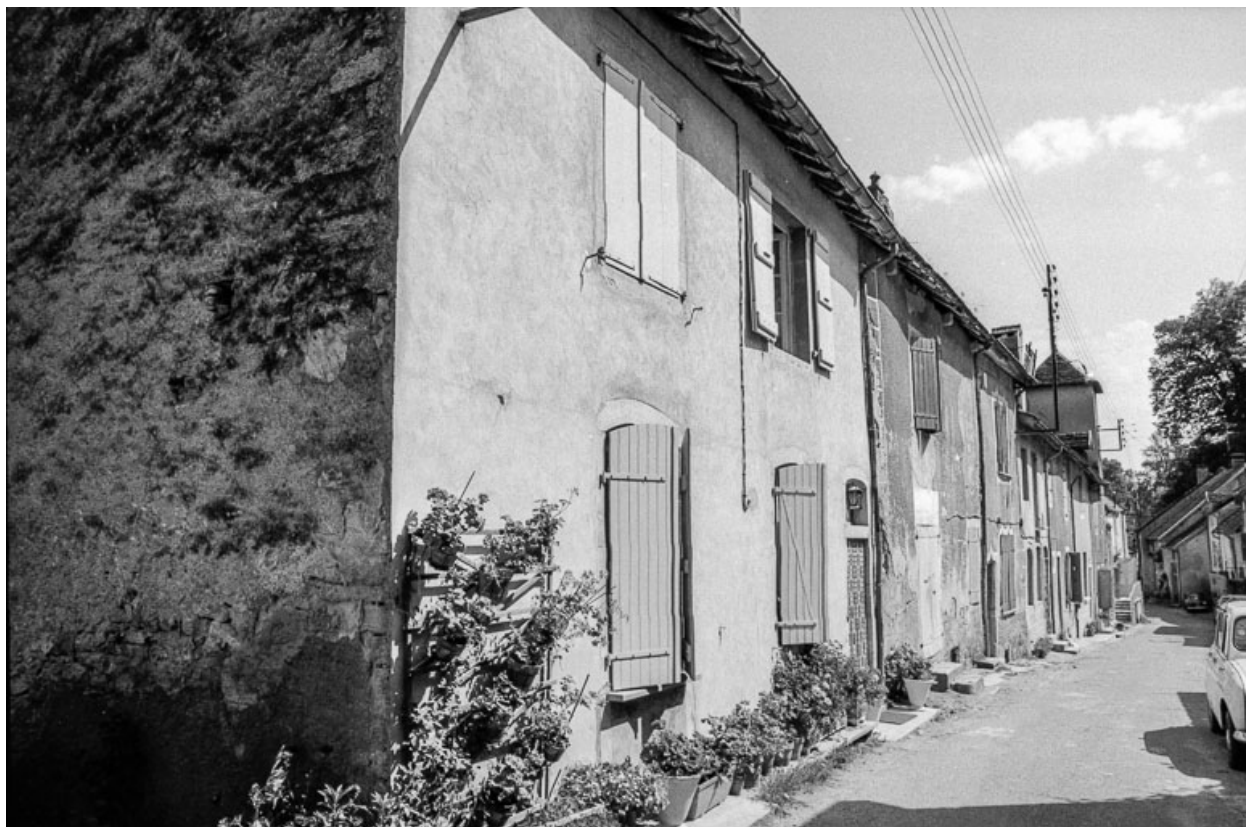
Maisons rue Haute-du-Bourg : façades sur rue.
