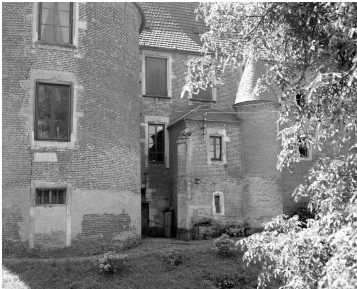
Elévation postérieure, détail.
