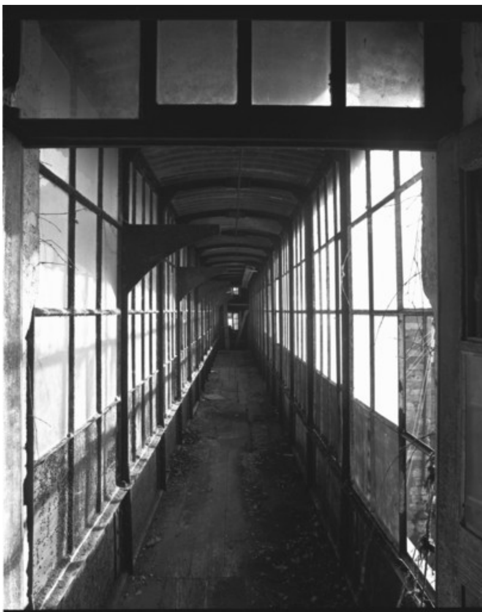
Intérieur de la passerelle en 1989.
