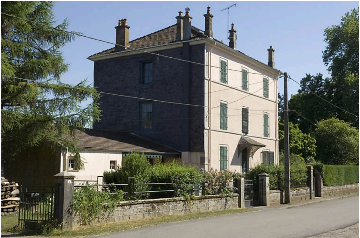
Logement patronal sud. Vue de trois quarts.
