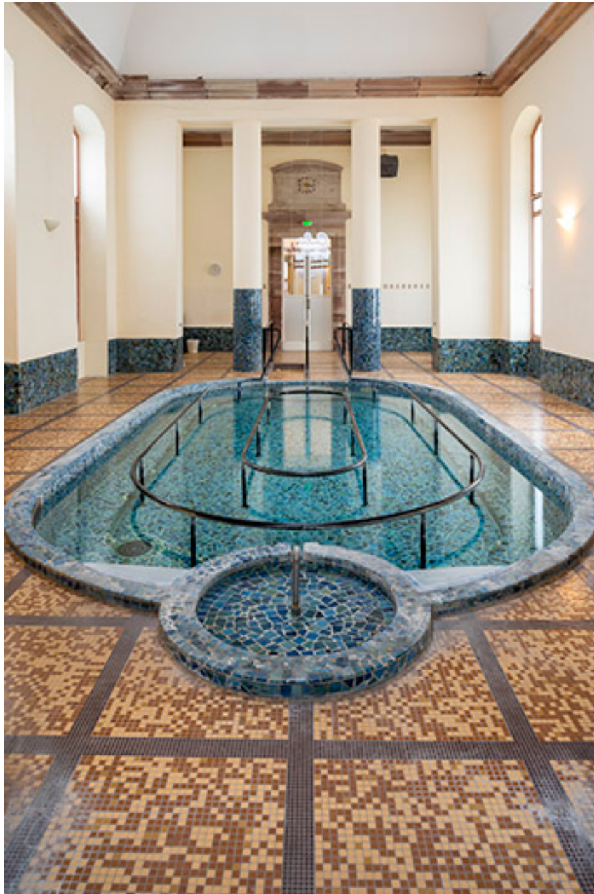
Piscine à l'emplacement du Grand Bain, bassin, vue en direction de l'est.
