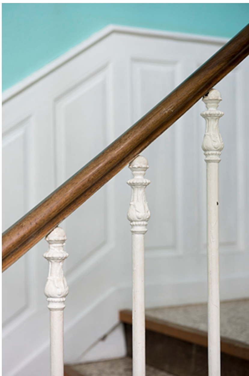
Détail de la rambarde et du garde-corps.
