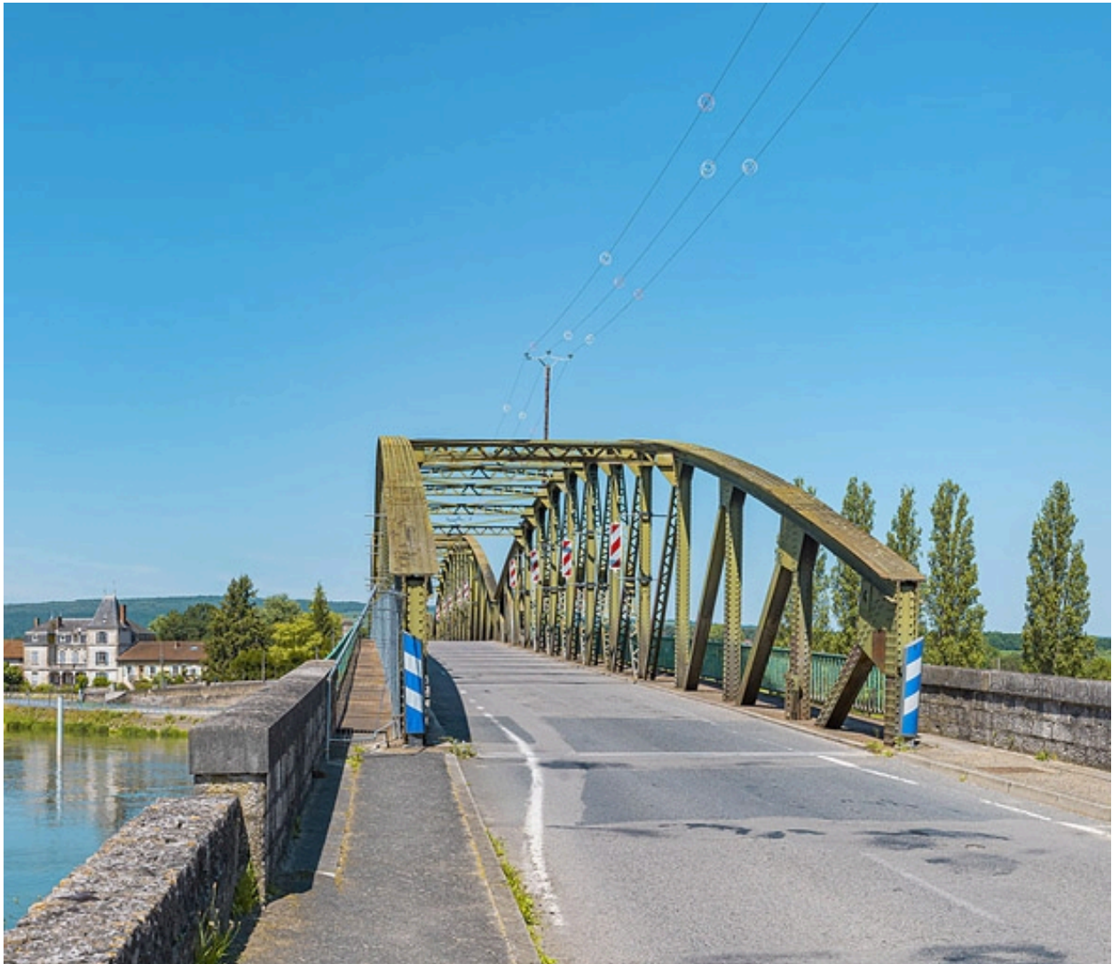
Le pont de Fleurville, depuis la rive gauche.
