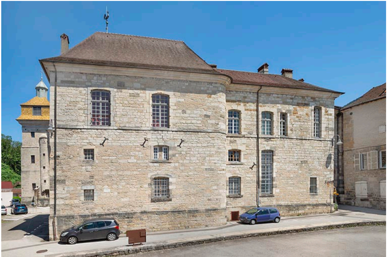
Elévation sud, depuis le sud-ouest.
