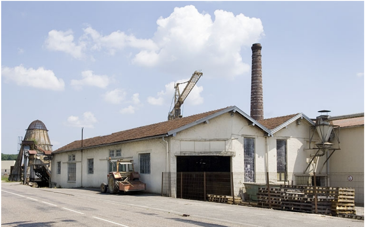
Atelier de fabrication (scie à ruban).
