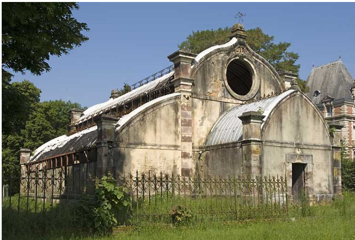
Serre. Vue depuis le sud-est.
