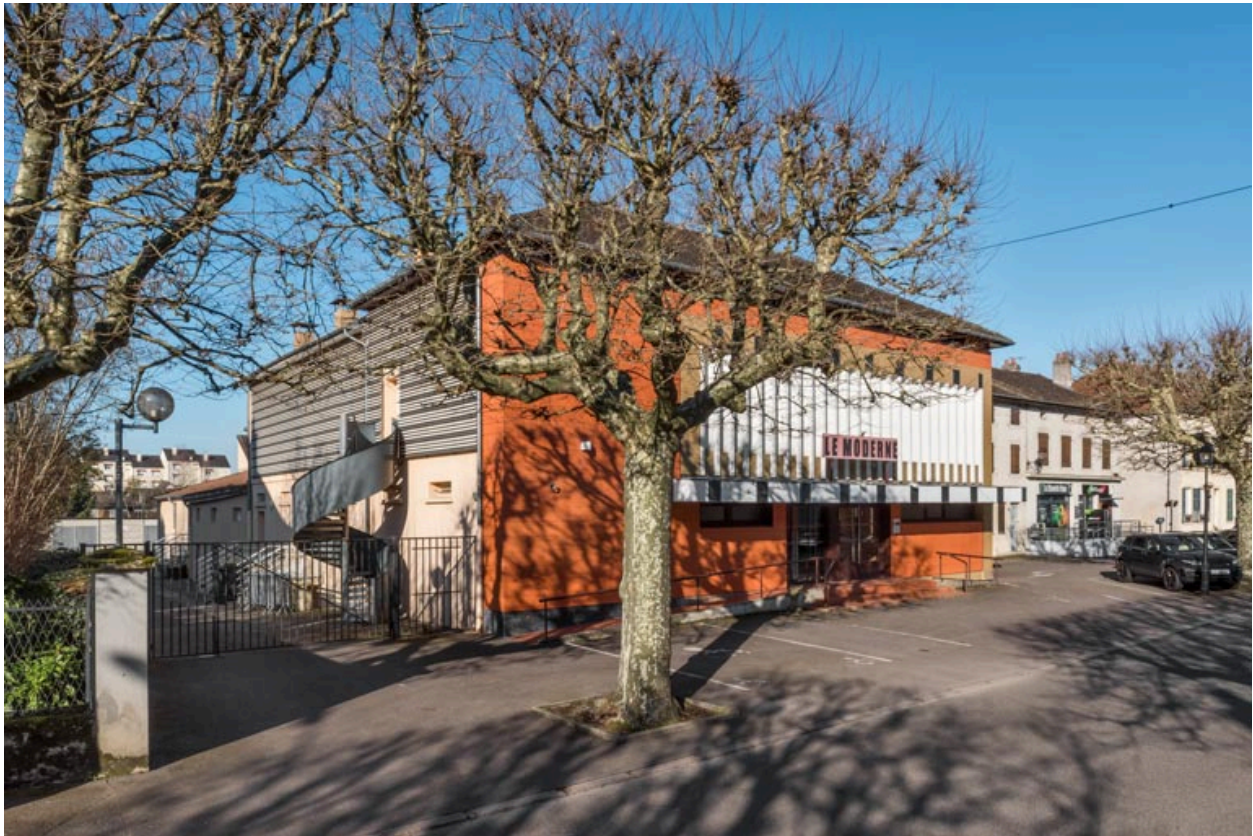
Vue d'ensemble, depuis l'avenue au sud-est.
